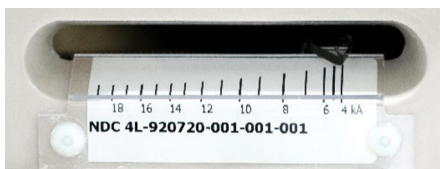
DAT setting window: Setting range: 4~18kA
